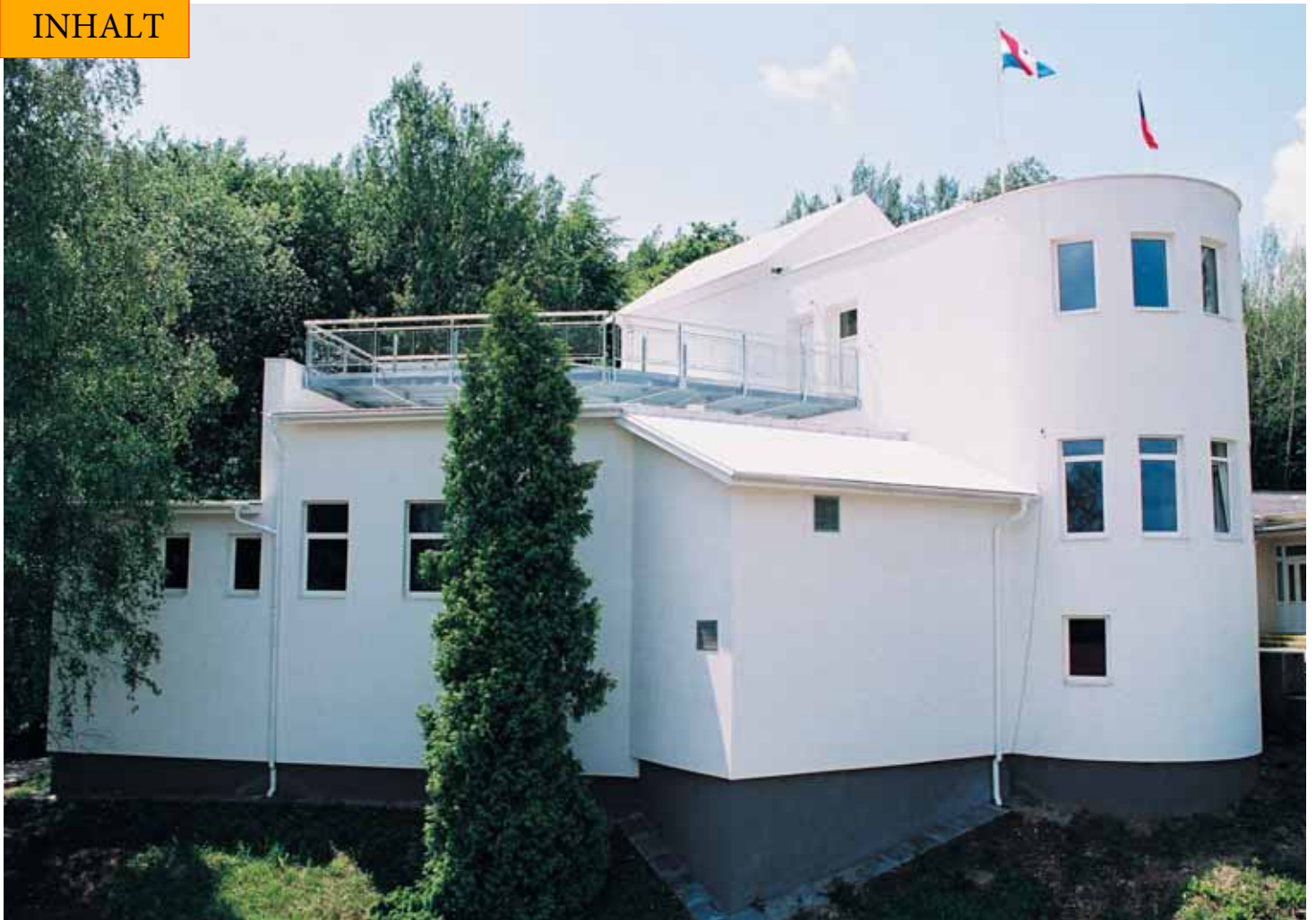
Sternwarte – Gebäude nach Renovierung
