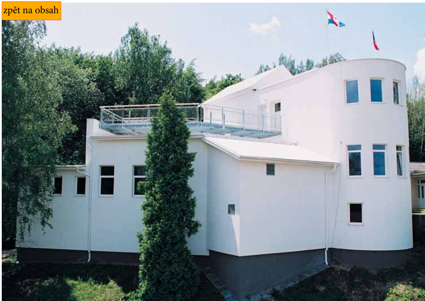
Hvězdárna – budova po rekonstrukci
